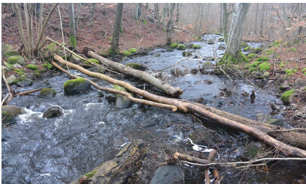
Figur 10. Fotografi efter åtgärd vid Klintarp, Klövbäcken. Block och sten har tagits från rensvallar längsmed strandkanten och lagts tillbaka i bäckfäran.
